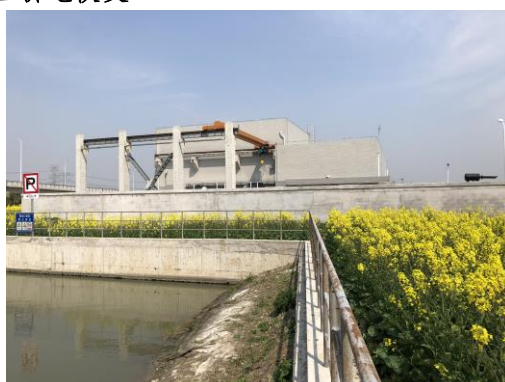
护岸扶壁式挡墙
