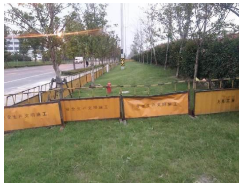
管线施工扰动控制
