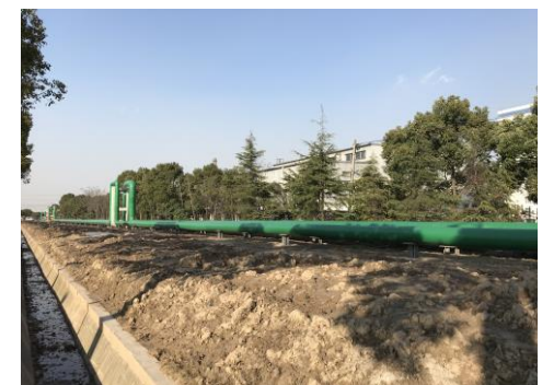
供热管线区土地整治
