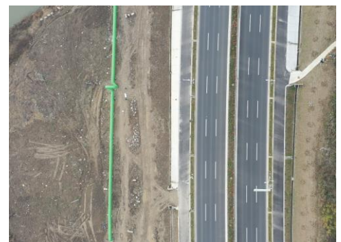
供热管线区土地整治
