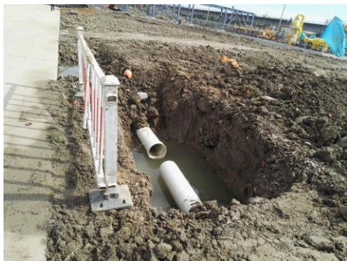
厂区雨水管道
