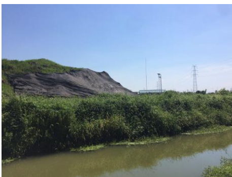
施工生产生活区临时堆土苫盖
