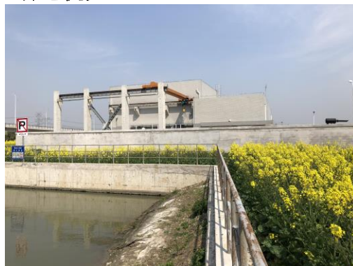
护岸扶壁式挡墙
