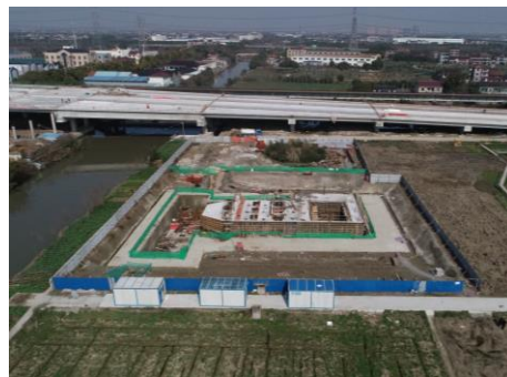
取水设施区彩钢板拦挡
