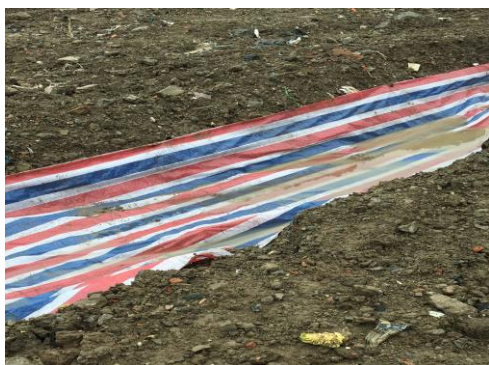
施工生产生活区临时排水沟
