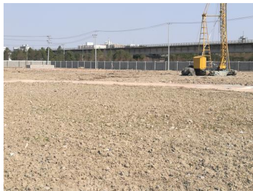
施工生产生活区耕地恢复
