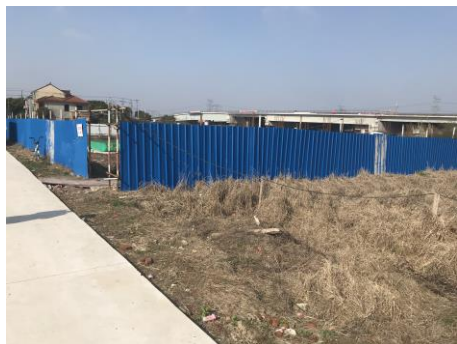
厂区彩钢板拦挡
