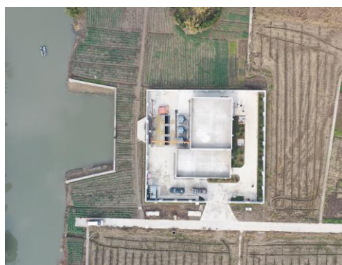
取水设施区种植灌木、铺设草皮
