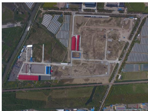
厂区表土剥离
