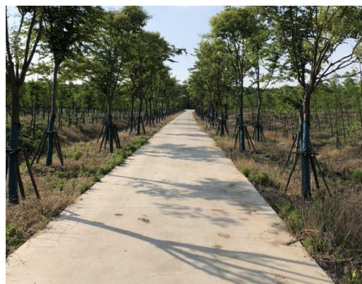
排水管线撒播草籽
