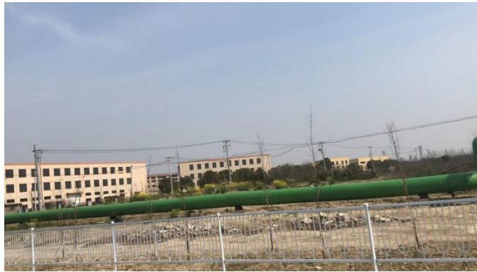
(5) 厂区南侧——天华路段，供热管线扰动范围未恢复绿化，需进行土地整治、撒播草籽，恢复植被。2020.3.17
