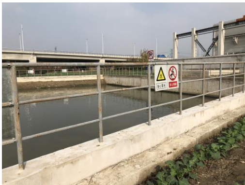
取水设施区护岸扶壁式挡墙
