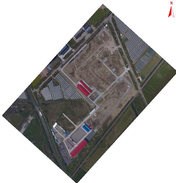
厂区及施工生产生活区扰动情况 2017.3.1
