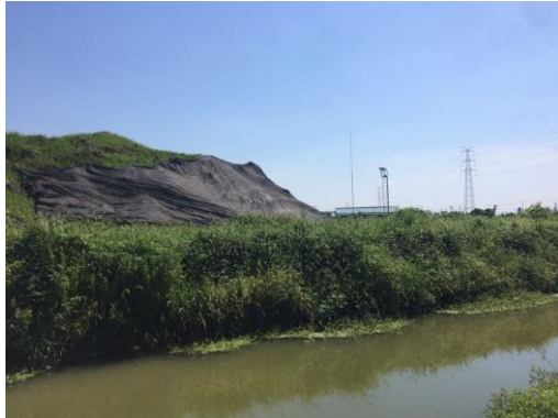
施工生产生活区临时堆土苫盖
