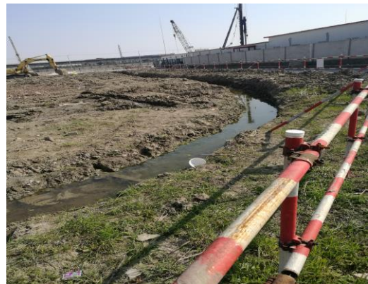
厂区临时排水沟
