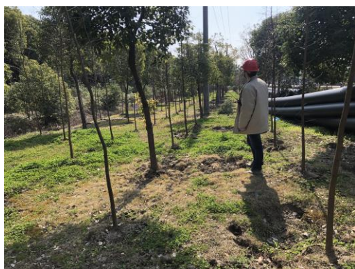
取水管线撒播草籽
