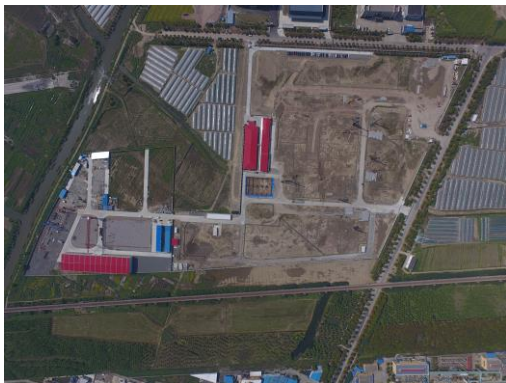
厂区表土剥离
