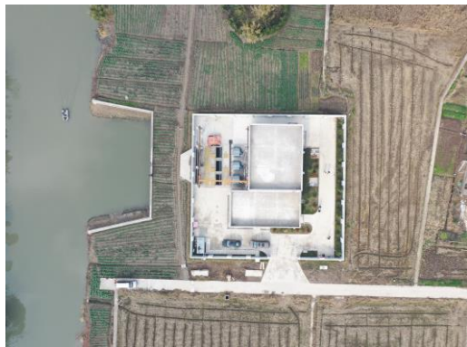
取水设施区耕地恢复
