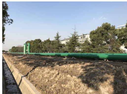
供热管线区土地整治
