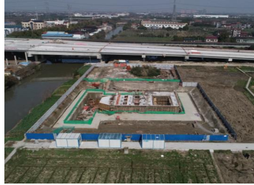
取水设施区彩钢板拦挡
