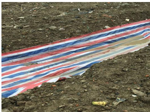
施工生产生活区临时排水沟
