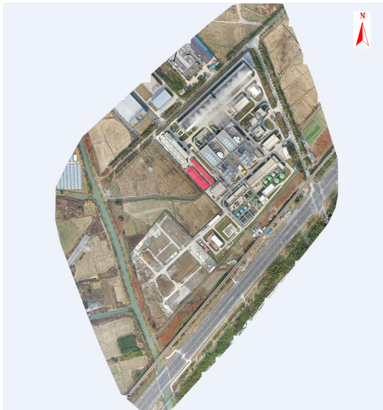
厂区及施工生产生活区扰动情况 2019.12.27
