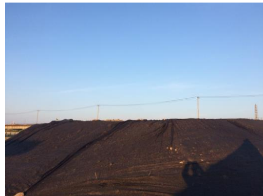
施工生产生活区表土剥离
