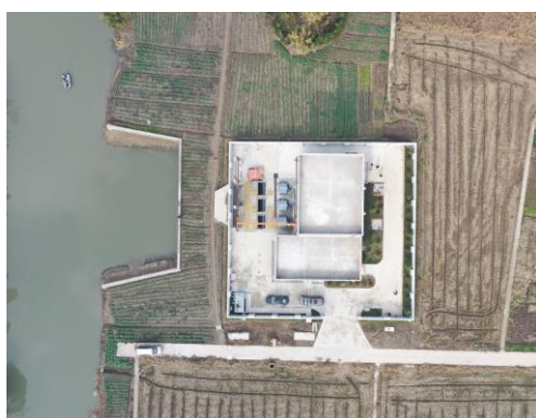
取水设施区种植灌木、铺设草皮
